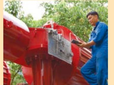
Rotork最近收购了K-Tork国际有限公司，该公司曾向Entergy公司位于美国阿肯色州雷德菲尔德市的White Bluff发电站提供了灰斗(AH系列)阻尼驱动系统，用于替换掉被证实性能并不可靠的气缸式执行器。那些系统安装于2006年并使用了5年，最近在检查中确认K型产品解决了该电站的一项关键性维护问题。这座火力发电站在2006年安装了136个K型AH系列阻尼驱动系统器，取代了原来性能不良的气缸执行器。这些部件通过高周“不间断”联接，从而消除了滞后现象并能使TK-2转子驱动器与现有的灰斗装置相匹配。经过了5年的使用仍无故障发生。既没有签发过任何维修单，也没有用到过备件或安装密封件，甚至没有因任何原因拆下过任何部件进行保养。
